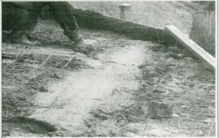
Aplicación de concreto con concremallas anclada
