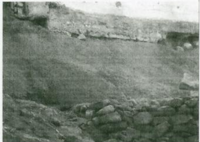
Se perfilo el talud y se colocaron pernos con varilla para garantizar la estabilidad de la concremallas en el momento de la aplicación del concreto
